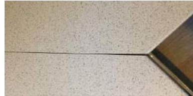
**JUNTAS APRETADAS, CAMPO (JOINTS TIGHT, FIELD):** Cualquier unión o combinación de juntas y/o elementos de fijación mecánicos que se utilicen para unirse a dos miembros en el campo. La distancia entre miembros no excederá de las establecidas en los presentes estandares.
